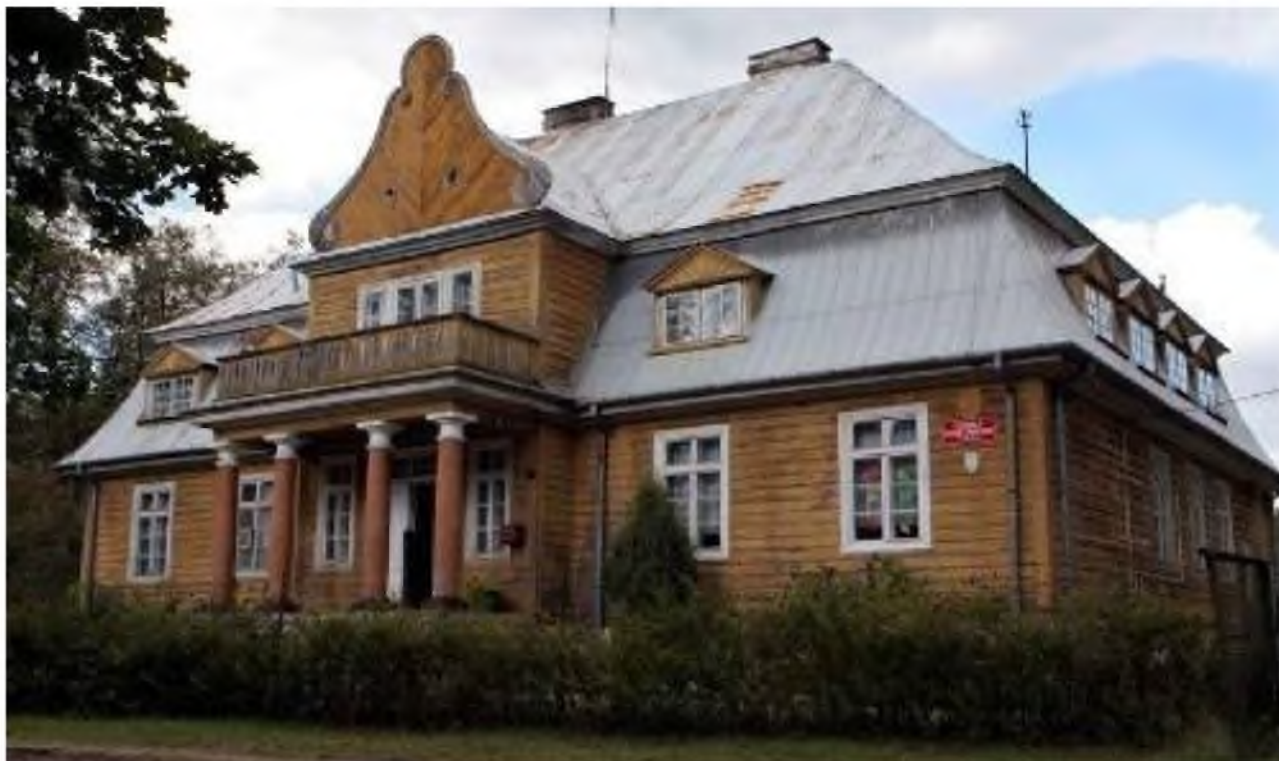
Zdjęcie 1. Obiekt dworku w Przystani przed remontem
