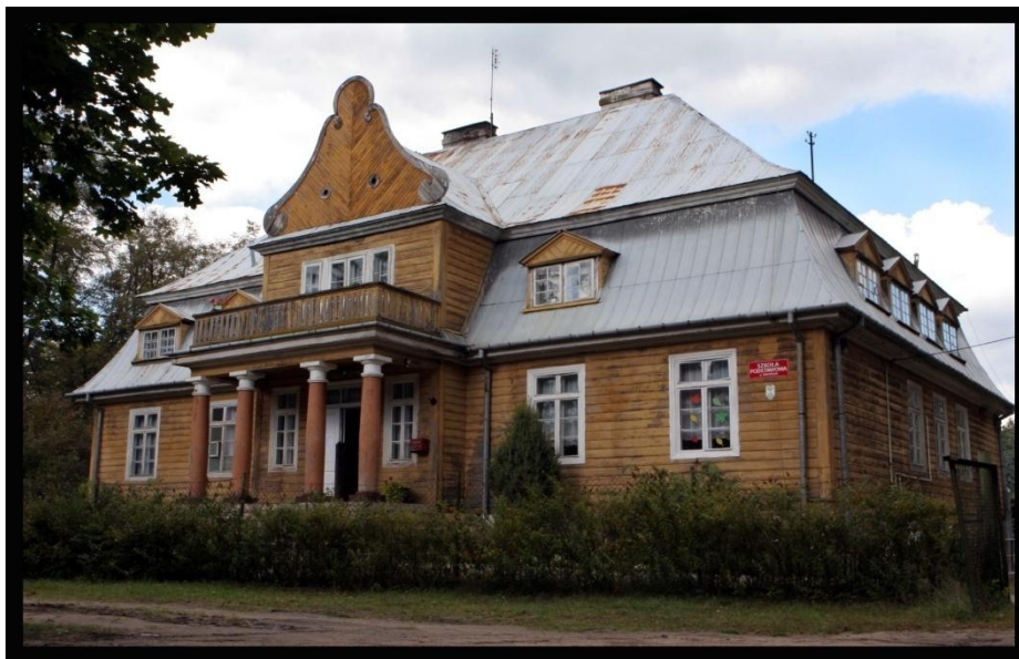
Zdjęcie 1. Obiekt przed remontem (Źródło: Opracowanie własne)
