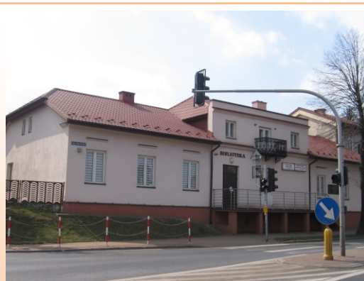
Budynek biblioteki w Zwoleniu
