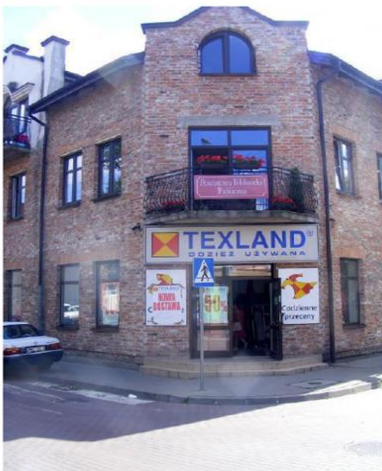
Fotografia 4. Przykład działalności gospodarczej prowadzonej na minimalnym poziomie rentowności w obszarze rewitalizacji. 9
