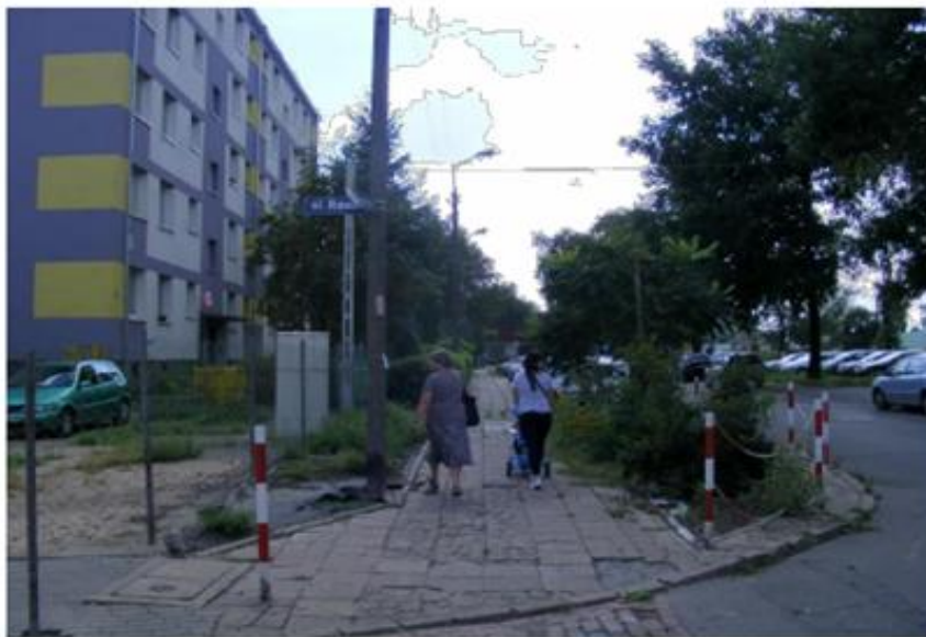
Fotografia 8. Zły stan infrastruktury pieszej w obszarze rewitalizacji. 12
